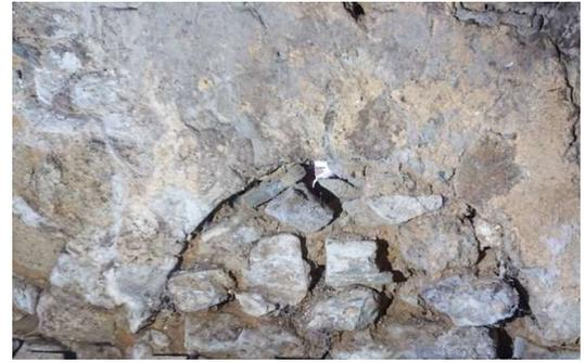
L'eau actionnait vraisemblablement la roue par-dessous en la faisant tourner par la force du flux. Les photos montrent le passage du bief et l'emplacement de la roue ainsi que le passage de l'axe de la roue dans la maçonnerie du pignon.
